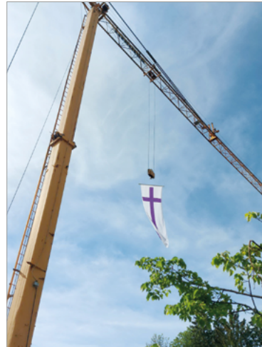
Passend zur Baustelle wehte die Kirchenfahne hoch oben am Baukran
